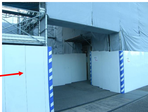
本部庁舎出入口
