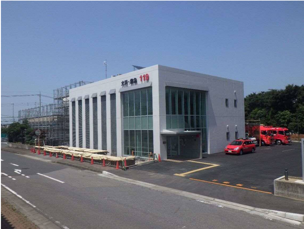
増築事務所棟全景、消防車両及び一般来庁者用駐車場出入口を撮影
