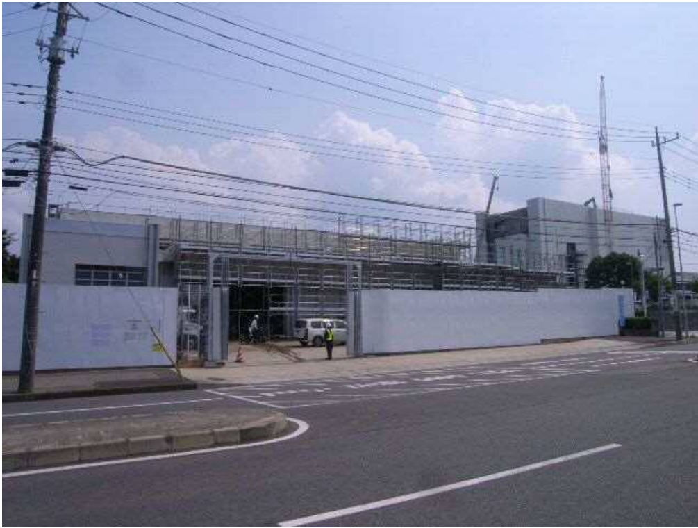
耐震改修工事中の既存棟を撮影
