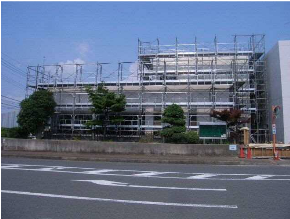
耐震改修工事中の既存棟を撮影
