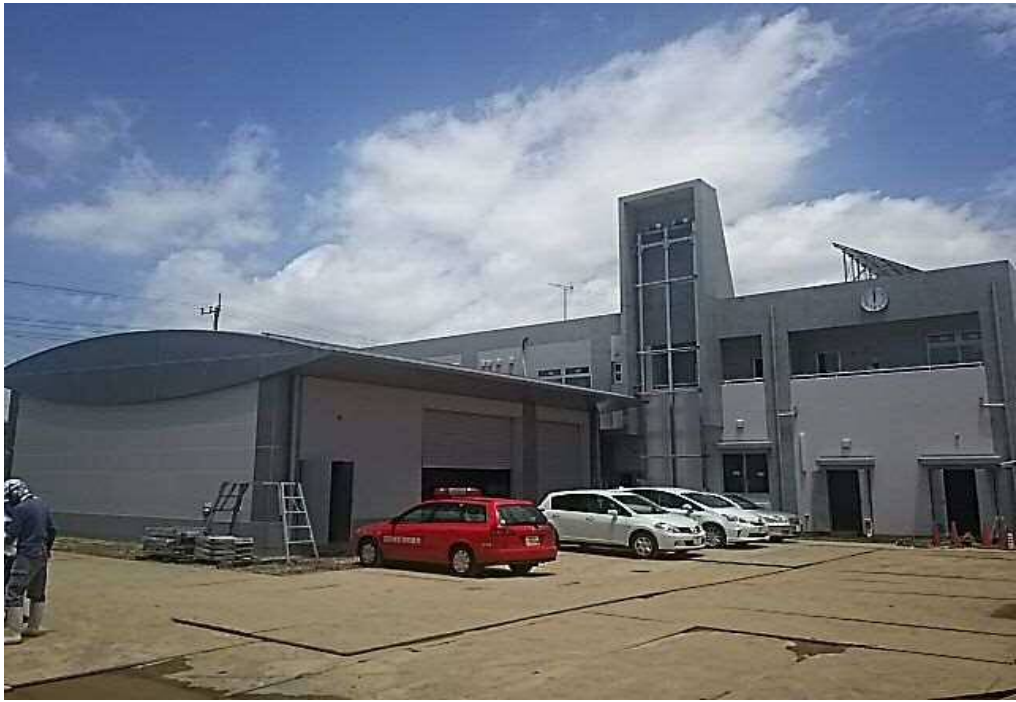
③ 6月17日 南側より車庫棟及び事務所棟を撮影（中央部はホース乾燥塔）
