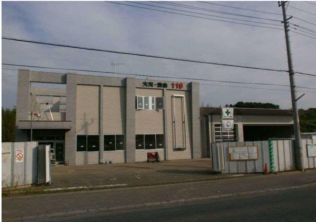
① 6月20日 国道側より事務所棟及び車庫棟正面を撮影
