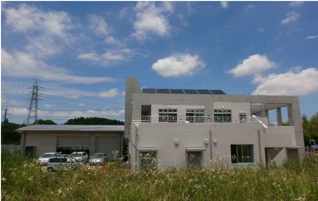
④ 6月17日 南東側より車庫棟と事務所棟を撮影
